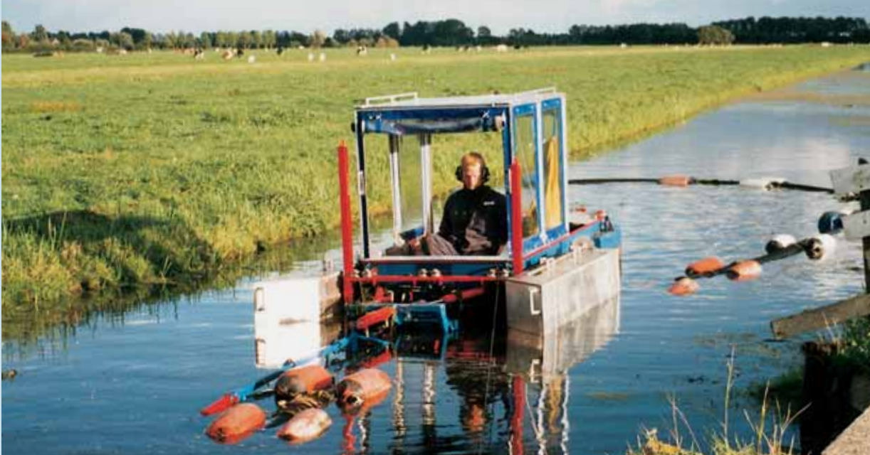
Baggeren voor waterkwaliteit en diepte
